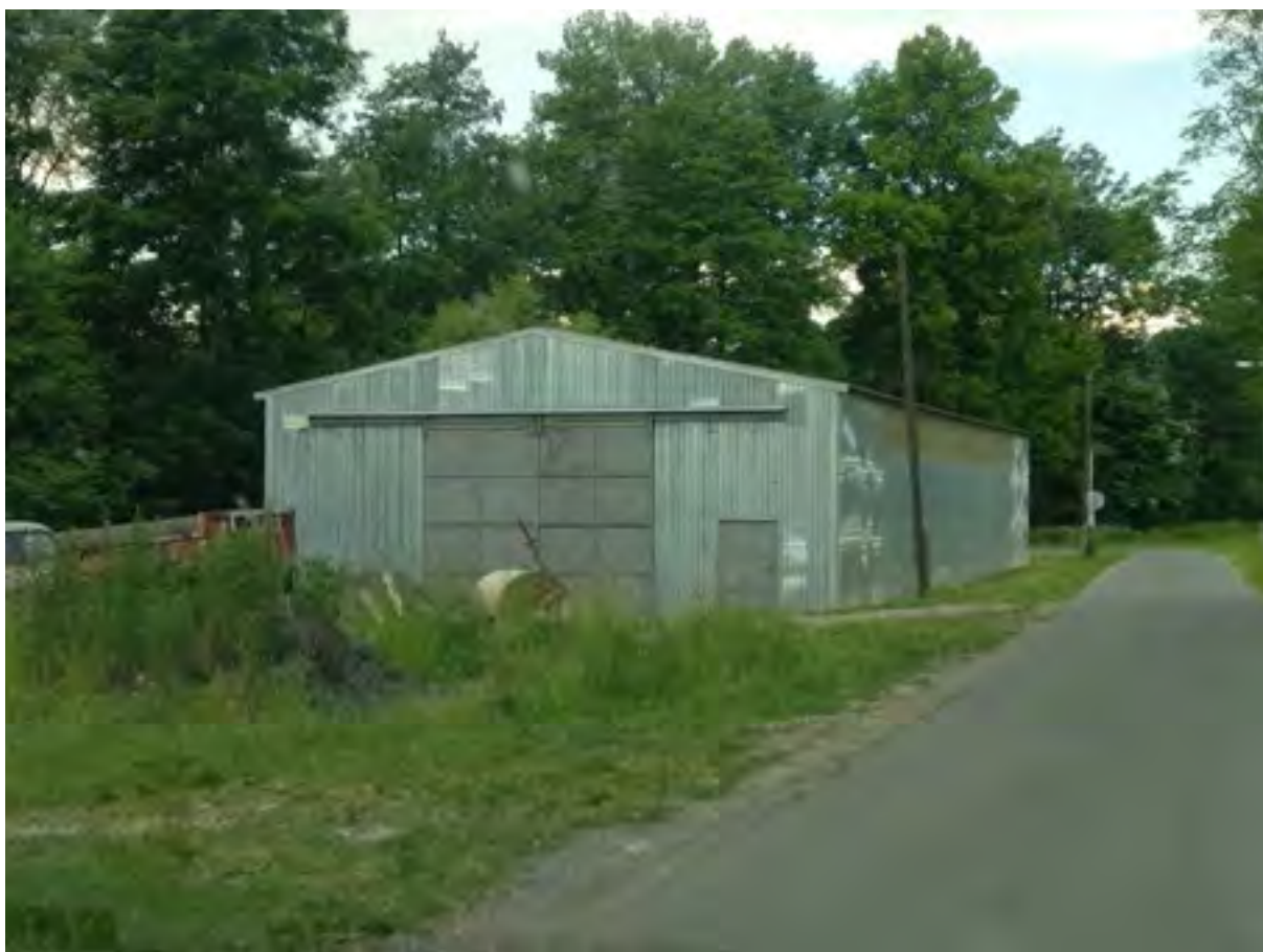
Obr. 20 - Ocelové montované haly v centru Václavova u Bruntálu
