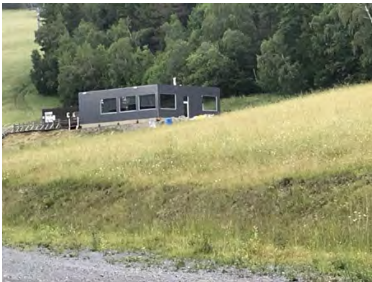
Obr. 43 - Rovné střechy staveb u LD Čerták, Václavov u Bruntálu
