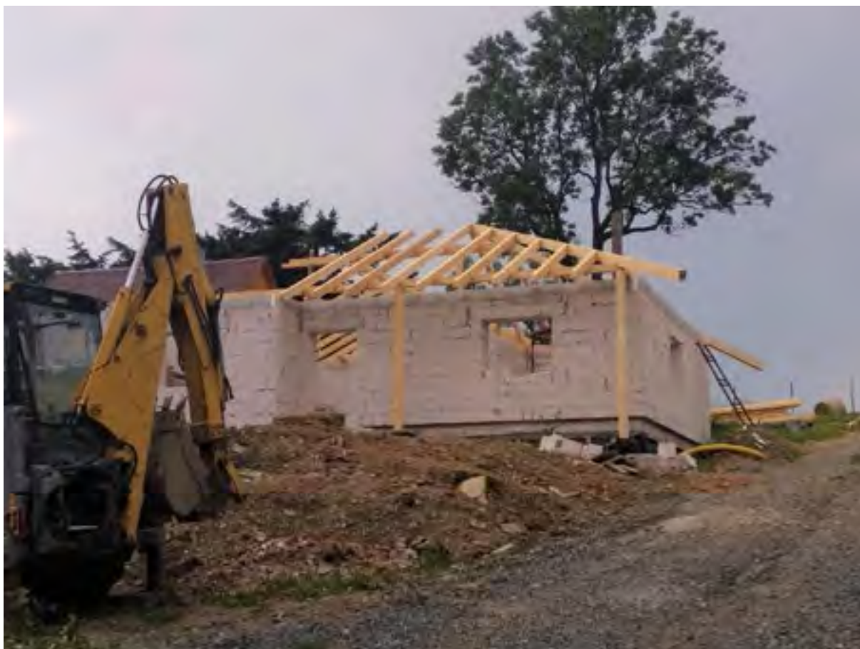
Obr.30 - Novostavby Václavov u Bruntálu - valbová střecha Bungalowu
