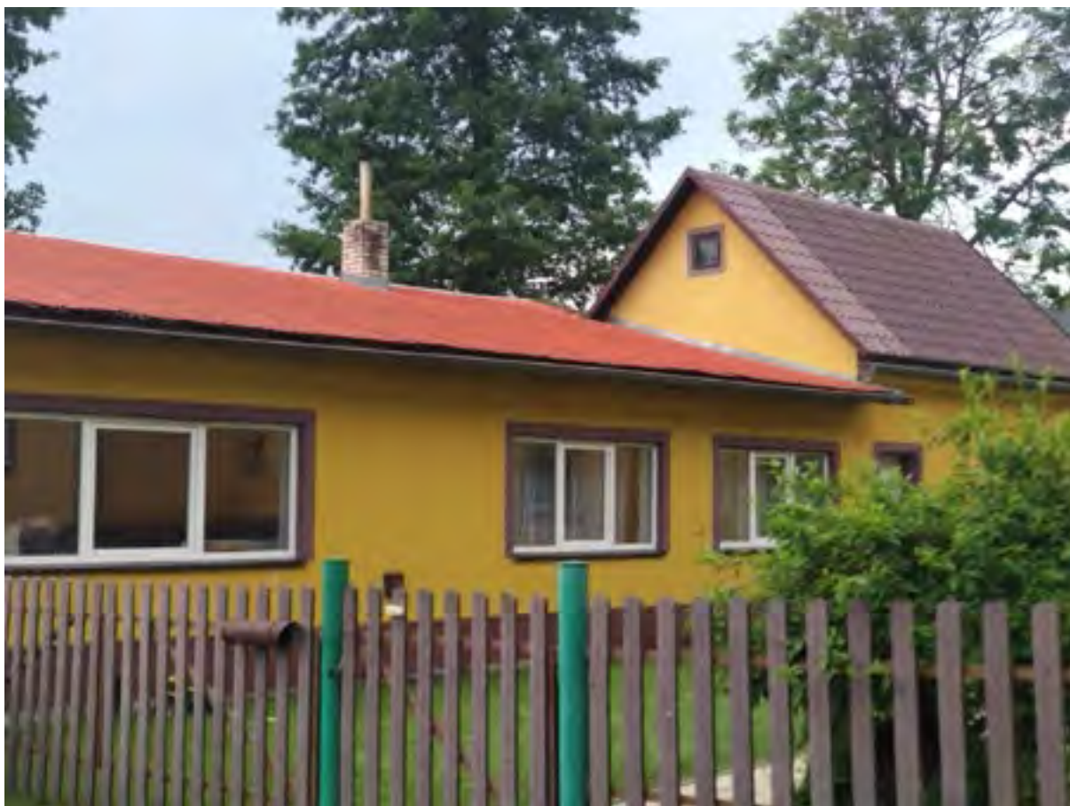
Obr. 33 - Pultová střecha přístavby, Václavov u Bruntálu
