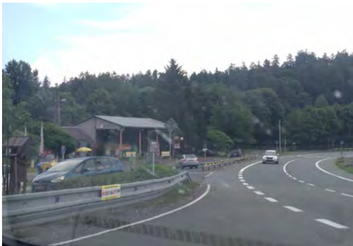
Obr. 21 - Čerpací stanice pod zemědělským areálem ve Václavově u Bruntálu železo-betonová stavba v centru obce
