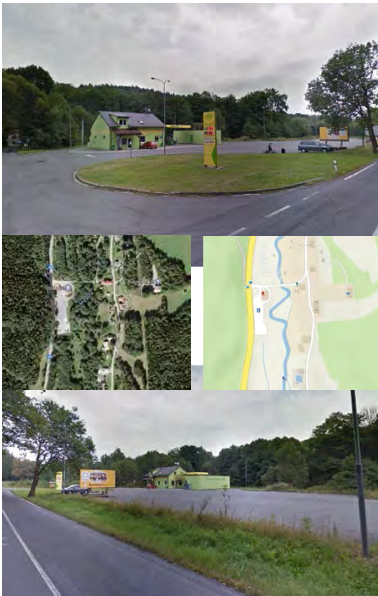
Obr. 23 - Čerpací stanice u řeky Moravice - pod Čertovou horou, směr Malá Morávka
