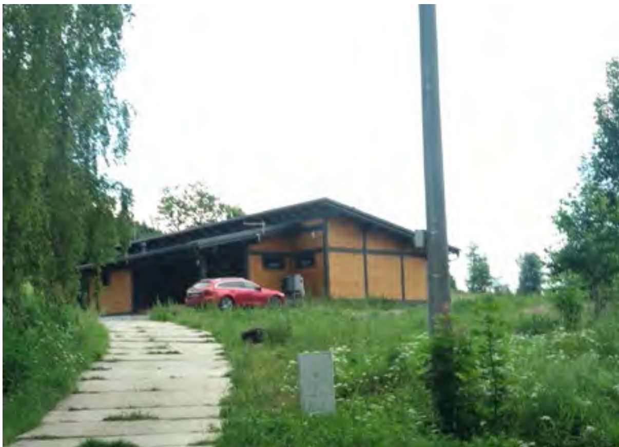
Obr.31 - Novostavby Václavov u Bruntálu – složená pultová střecha
